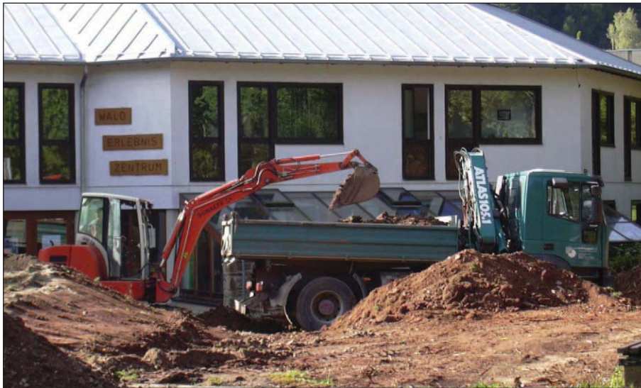
Bauarbeiten am Walderlebniszentrum in Gemünd laufen seit September auf Hochtouren
