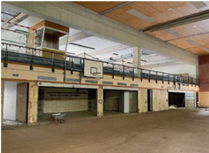
Geräteraumtore, Boden und Prallschutz wurden durch das Hochwasser komplett zerstört.
