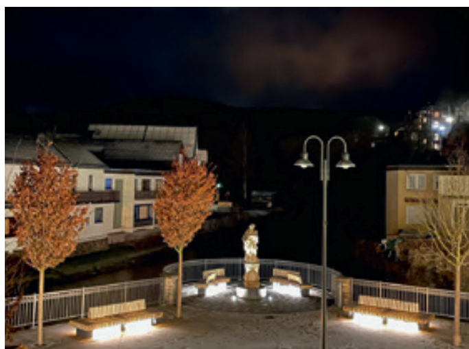
Im Zuge der Baumaßnahme wurde am Nepomukplatz eine neue Beleuchtung installiert. (© www.gkli.de )
