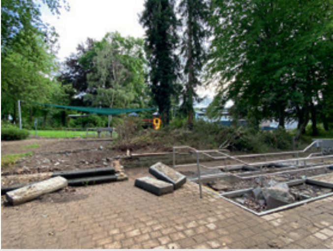
Nach der Flut im Juli 2021 ist vom Barfußpfad und dem Bereich rund um das Tretbecken herum nicht mehr viel zu erkennen.
