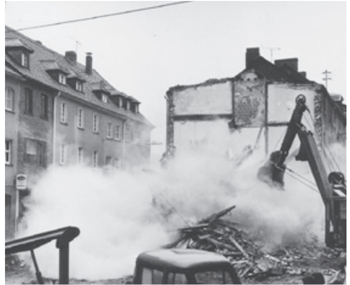
Abbruch des Gebäudes der AOK in Schleiden, 1968. Foto: Stadtarchiv
