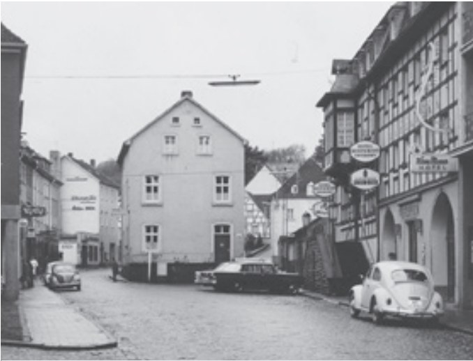
Blick auf die Häuserzeile zwischen der Stein- und Huppenstraße, die abgerissen und durch die platzartig verbreiterte Straße „Am Markt“ ersetzt wurde, die vorrangig als Parkplatz dient. Foto: Stadtarchiv
