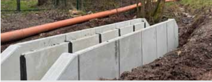
Im Februar wurde das neue Profil im Bereich des Wohngebietes „Unterm Dorf“ in Gemünd eingebaut.
