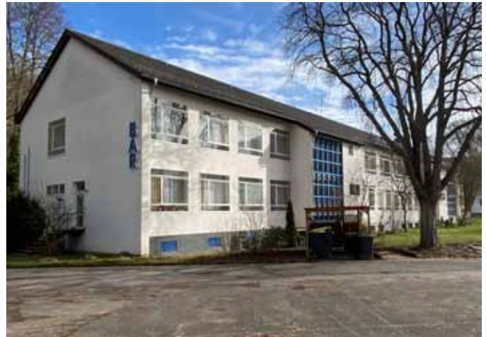
Im April wird mit den Abrissarbeiten des Katharinenhofs in Gemünd begonnen. Die Ansicht zeigt das Gebäude vom Parkplatz hinter dem Kurhaus aus.
