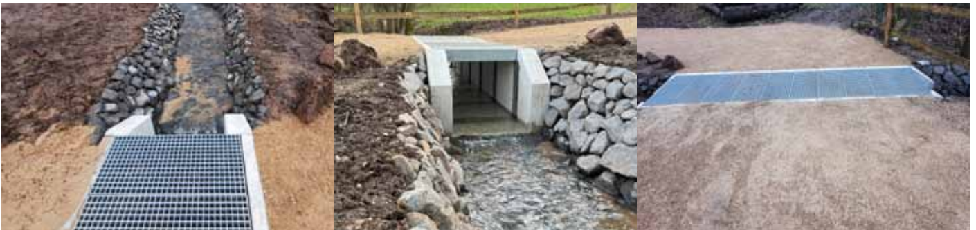
Durch das Oberflächengitter kann das Niederschlagswasser, was über den Wirtschaftsweg hinunterläuft, abgeführt werden. Der gesamte Uferbereich wurde mit Wasserbausteinen gesichert und damit optisch aufgewertet.
