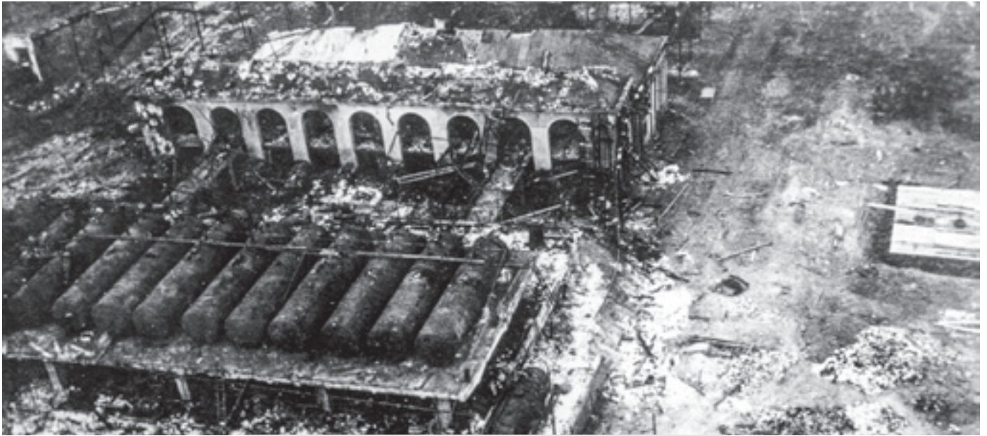
Teilbereich des Werkes nach den Explosionen. (© Frieze-Selbstädt)
