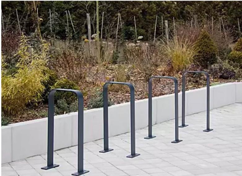
Fahrradbügel aus Flachstahl
