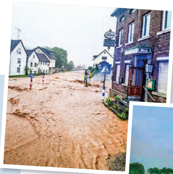
Bereits am Nachmittag des 14. Juli 2021 überflutete der teilweise verrohrte Rinkenbach in Oberhausen auch die Bundesstraße, die danach bis zum Ende der Flut nicht mehr befahrbar war. (© Florian Schmitz)
